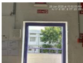
23. Exit door 1.JPG
